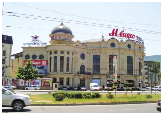
ТОРГОВЫЙ ЦЕНТР «МИРКАТО» Махачкала, 590 квТ
