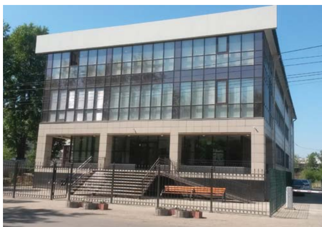
КОЛЛ-ЦЕНТР «ТЕЛЕ2» Иркутск, 300 квТ
