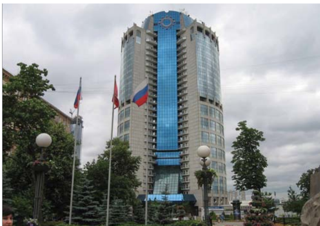
ГУП «МОСВОДОСТОК» Москва, 440 кВт
