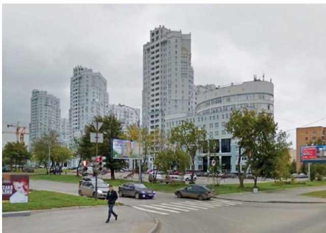
БИЗНЕС-ЦЕНТР «ТАТИЩЕВСКИЙ» Екатеринбург, 500 кВт
