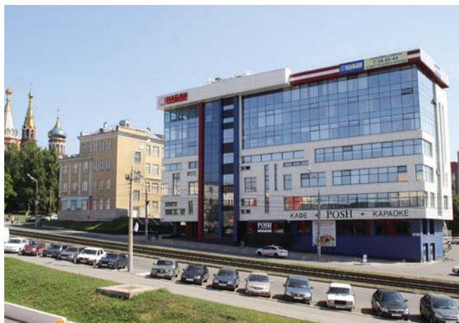
БИЗНЕС-ЦЕНТР «НАЙДИ» Ижевск, 498 кВт
